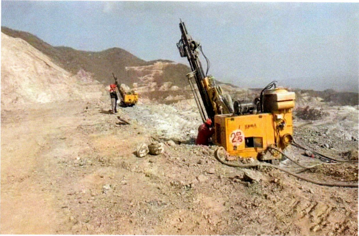
980、970 平台现场整改照片
