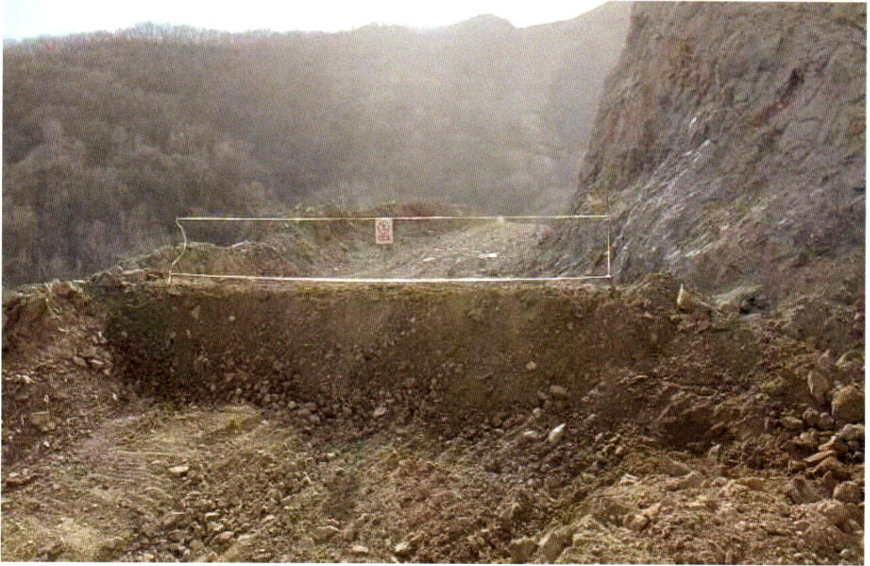
西山采场边坡下方道路封闭照片
