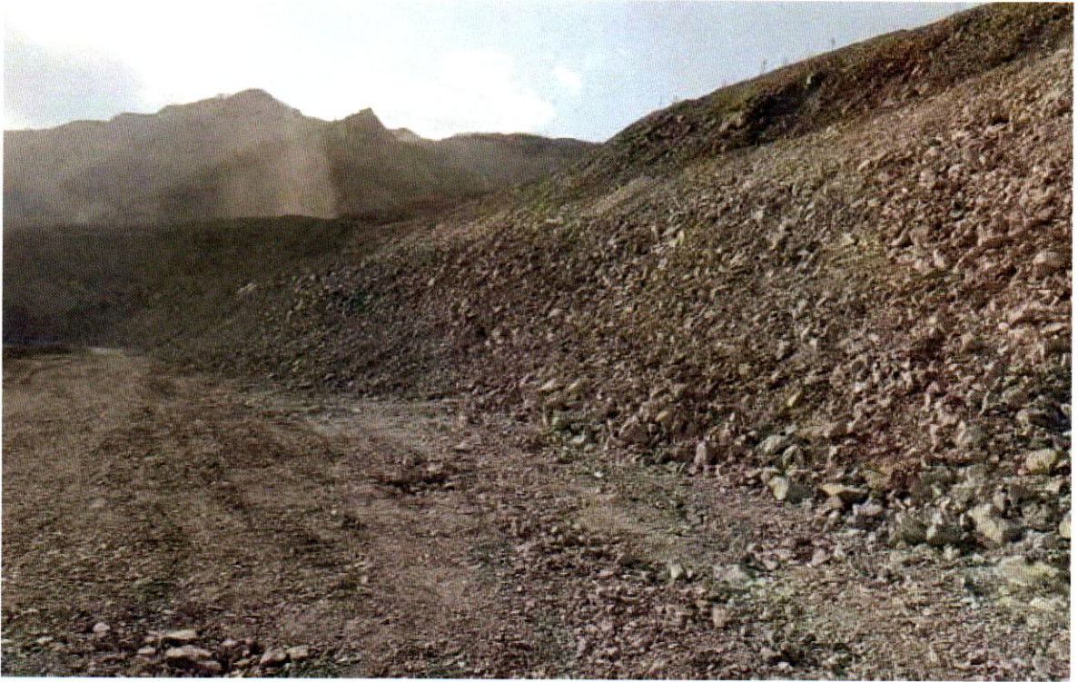
980、970 平台清理浮石后照片
